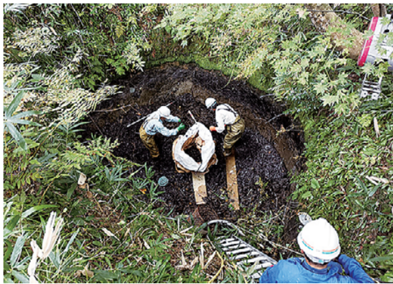
井戸さらい作業の様子。はしごで井戸の中に入り、堆積物を掘り出した(上新開発提供)
